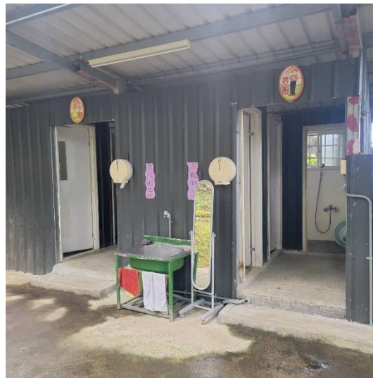
兩處廁所，一處 2~3 間廁所及 2 間浴室。8 間浴室建蓋中。
